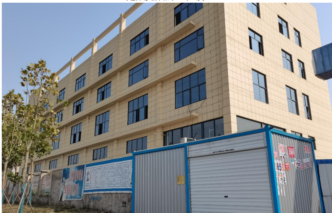
已建成完成的 3# 厂房
