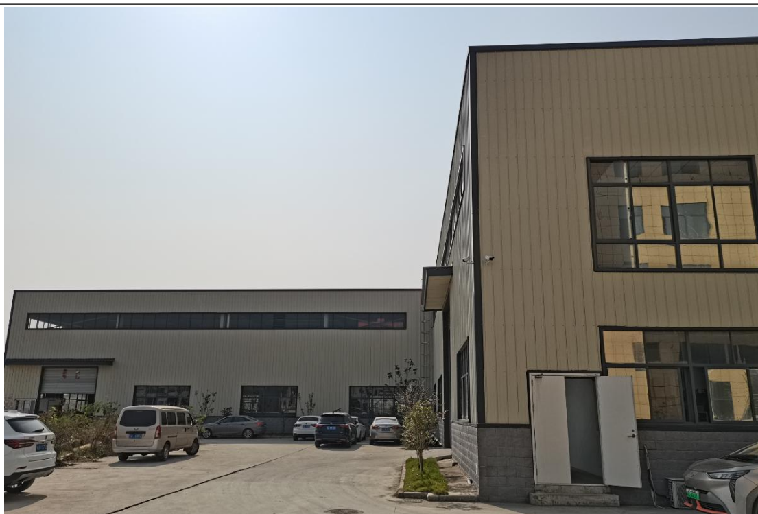
已建成完成的 4# 厂房
