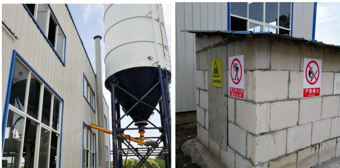
15m 高排气筒
