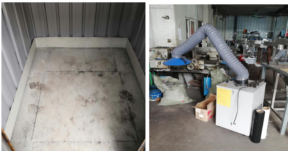
危废暂存库防渗漏全满焊金属托盘
